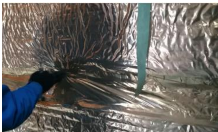
Figure 30 : adhésif maroufflé sur l'isolant
