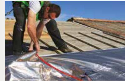
← **Dérouler l'isolant TRISO HYBRID'** horizontalement sur l'ossature bois réalisée en prenant soin d'orienter la languette adhésive en direction de la sablière et l'agrafer en respectant les règles essentielles de mise en œuvre. Commencer la pose en partant de la sablière et en remontant jusqu'au faîtage.
