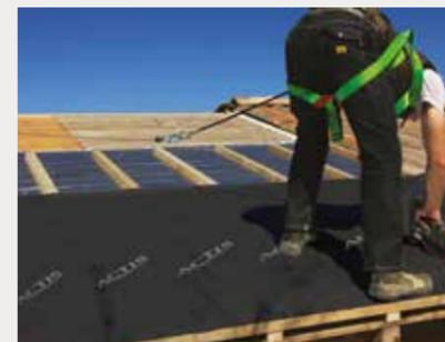
← **Dérouler à l'horizontale l'isolant BOOST'R HYBRID'** en partant de la sablière. Agrafer BOOST'R HYBRID' tous les 30 cm sur les contre-liteaux et réaliser la jonction verticale des lés au droit d'un chevron en respectant la continuité de l'isolation et en garantissant l'étanchéité avec l'aide du MULTIDHESIF.
