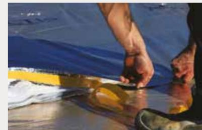
← **Poser horizontalement le deuxième lé** en respectant la continuité de l'isolation et de l'étanchéité à l'eau et à l'air. Agrafer les lés tous les 5 cm sur les entretoises préalablement installées et assurer la jonction horizontale des lés à l'aide de la languette adhésive de recouvrement du TRISO HYBRID'. Respecter la continuité de l'isolation au faîtage.
