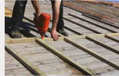
← **Fixer mécaniquement une ossature bois** (contre-liteaux de 60 x 40 mm minimum) dans la structure bois existante et au travers de la volige, y compris en périphérie pour assurer l'étanchéité à l'air de la toiture.
