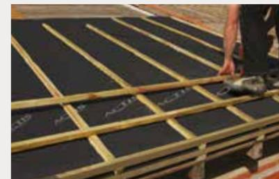
← **Fixer des contre-liteaux** de section 40x40 mm minimum au droit de la seconde rangée de contre-liteaux puis fixer perpendiculairement des liteaux 20x27 mm avec un écartement compatible avec la couverture choisie.
