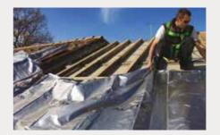
← Dérouler l'isolant Triso Hybrid<sup>3</sup> horizontalement sur les chevrons en prenant soin d'orienter la languette adhésive en direction de la sablière et l'agrafer en respectant les règles essentielles de mise en œuvre. Commencer la pose en partant de la sablière et en remontant jusqu'au faîtage.
