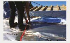
← Poser horizontalement le deuxième lé avec un recouvrement de 5 cm minimum sur le 1<sup>er</sup> lé pour la reprise en longueur.
